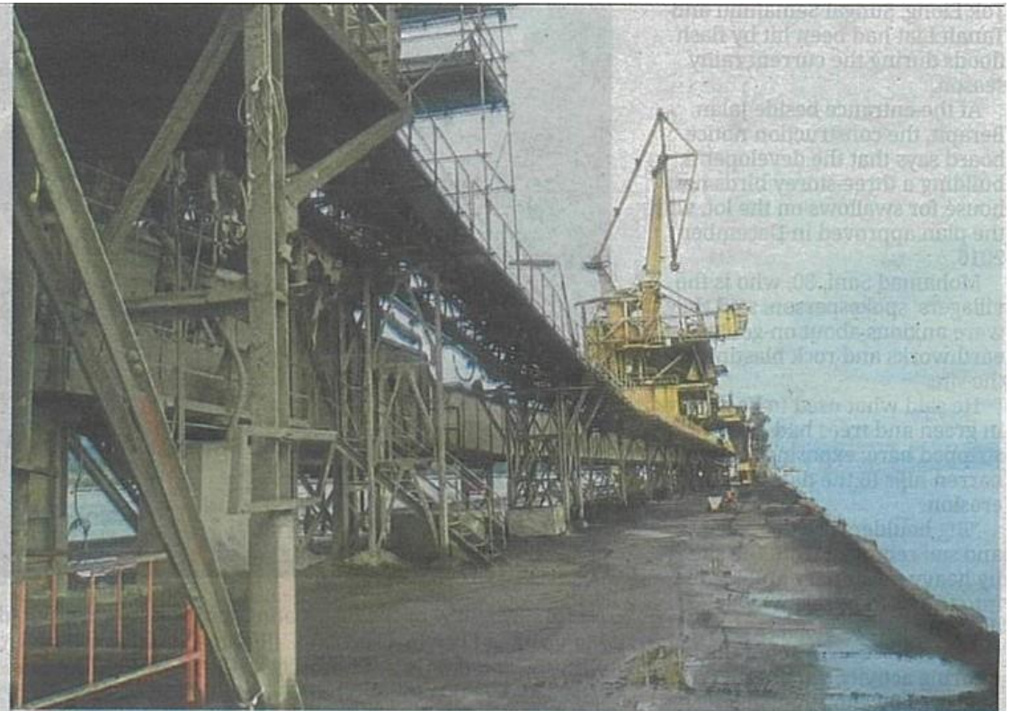
The Teluk Ewa Jetty in Langkawi.
